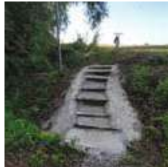
Réfection d'un escalier dans le Sentier Bois de Rebecq
